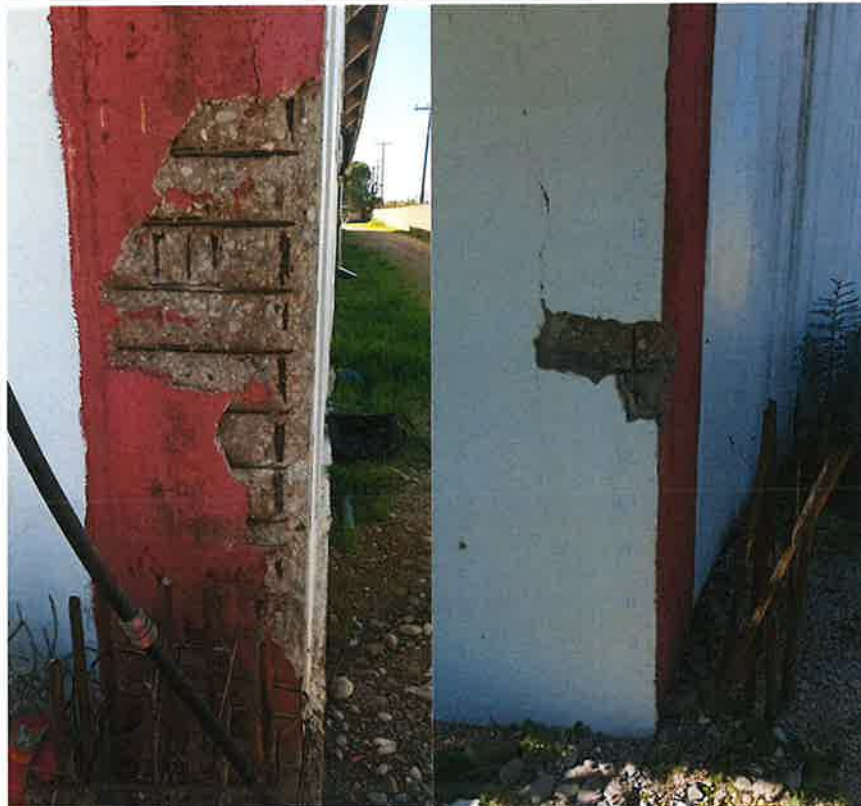
Φωτ. 1 Υποστυλώματα βόρειας όψης
