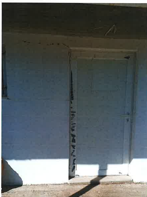
Φωτ. 2 Μικρορηγματώσεις αποκόλλησης τοιχοποιίας από το περιβάλλον πλαίσιο σκυροδέματος
