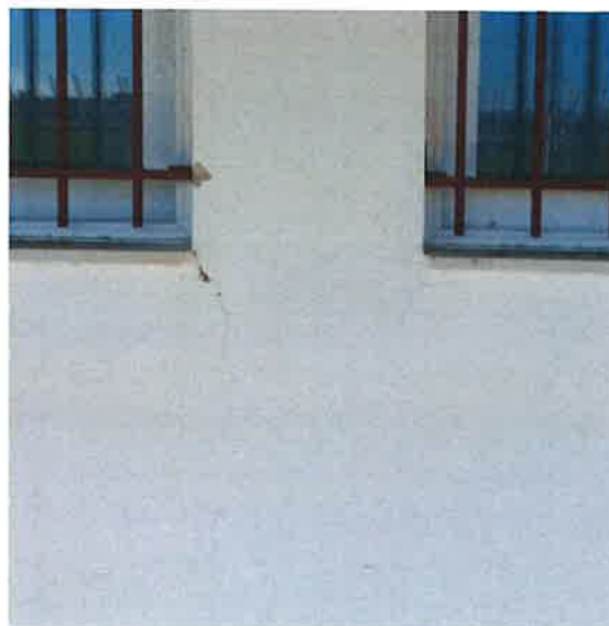
Φωτ. 2 Μικρορηγματώσεις αποκόλλησης τοιχοποιίας από το περιβάλλον πλαίσιο σκυροδέματος
