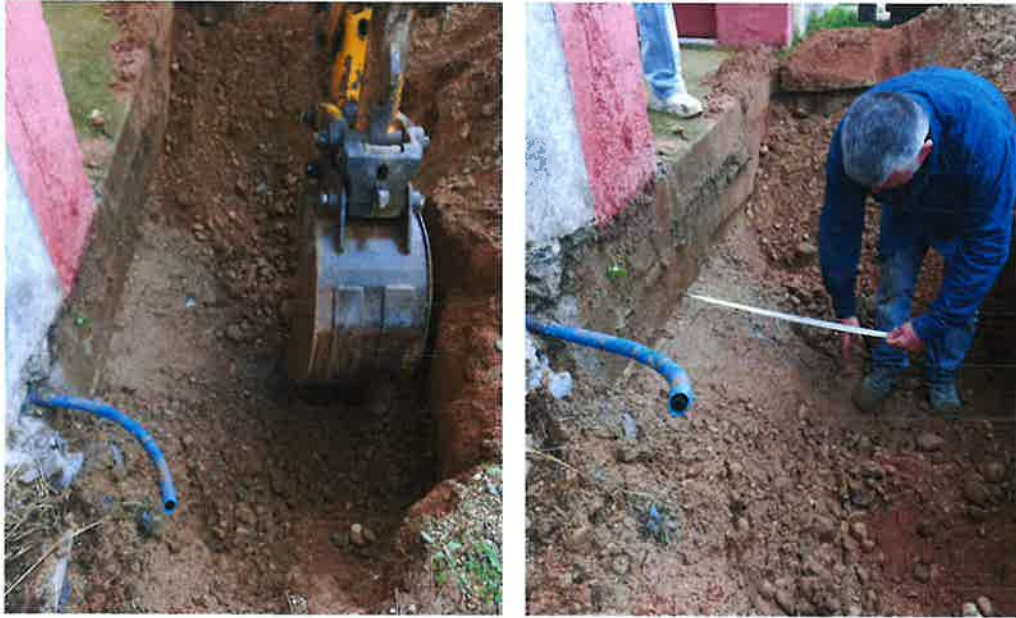
Εικ. 2.1 Διερευνητικά φρεάτια θεμελίωσης
